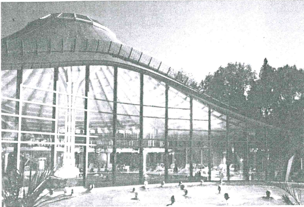
Bild 8: Solebad Bad Dürheim - Außenansicht
